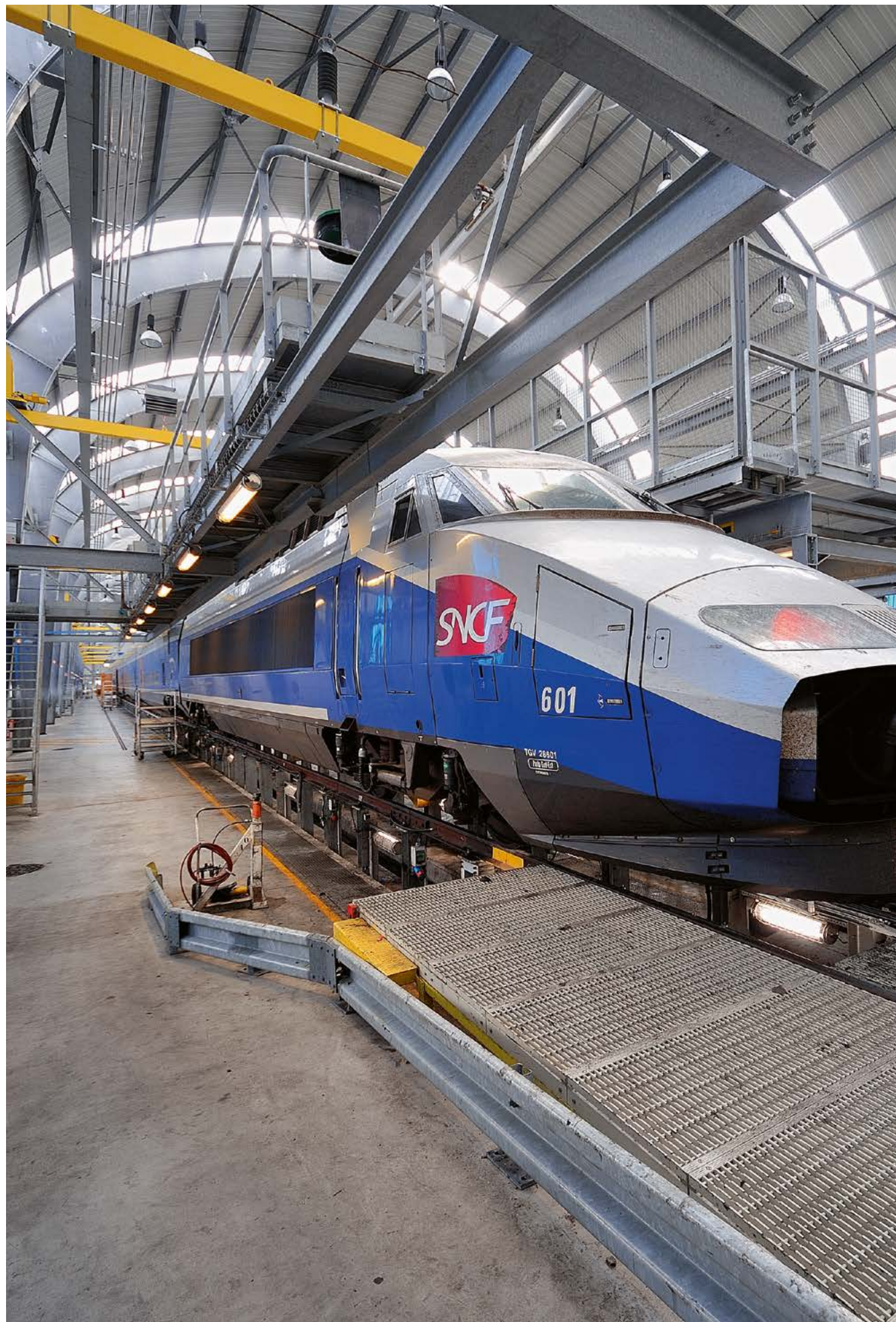
30 Wartungszentrum der SNCF (FR)
