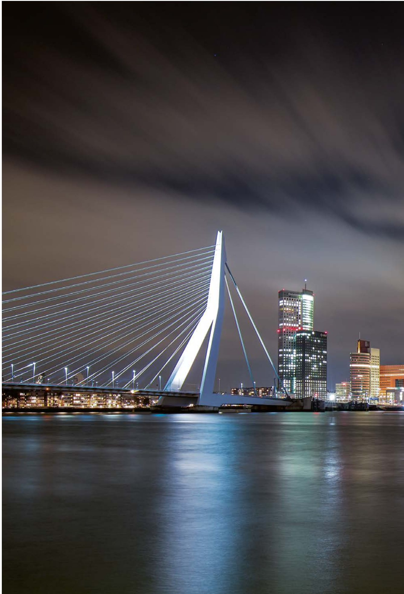
38 Erasmus Brücke, Rotterdam (NL), UNStudio, ATCLD
